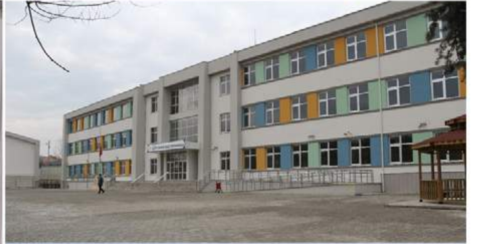
Kastamonu Merkez Şehit Şerife Bacı Ortaokulu 20 Derslikli Okul Binası ve Spor Salonu Yapım İş
