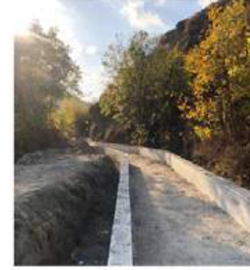
Tosya İlçesi Sapaca Köyü Sulama Kanalı Yapım İşi
