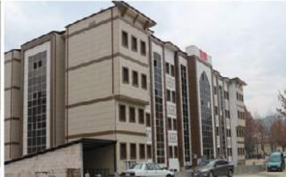
Merkez Rehberlik Araştırma Merkezi Yapım İşi
