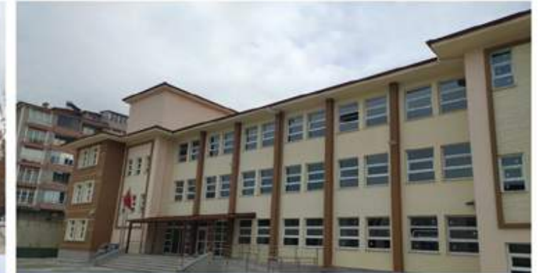
12 Derslikli Cide Cumhuriyet İlkokulu İkmal İnşaatı Yapım İşi
