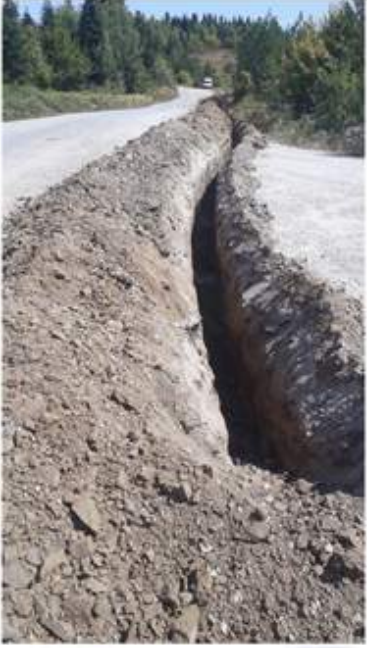
İnebolu İlçesi Kabalar Kuzluk Göçkün Köyleri İçme Suyu Kazı Çalışmaları
