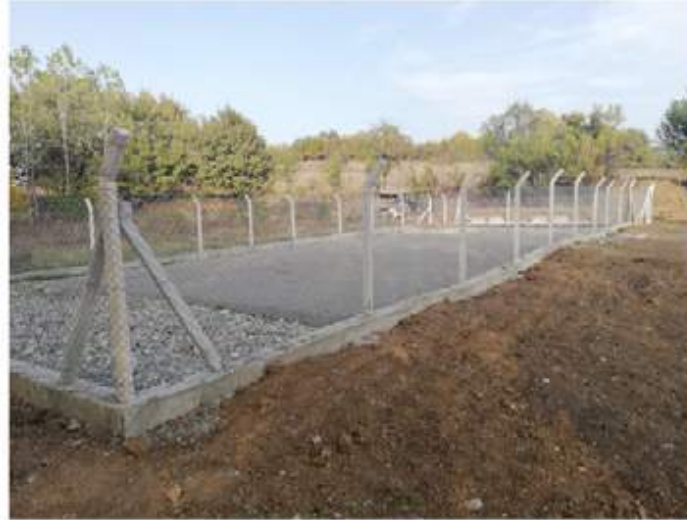
Taşköprü İlçesi Karşıköy Kanalizasyon Yapım İşi
