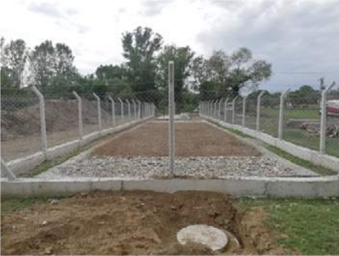
Taşköprü İlçesi Alatarla Köyü Fosseptik ve Arıtma
