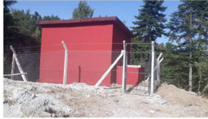
İnebolu İlçesi Kabalar Köyü İçme Suyu Deposu Yapım İşi
