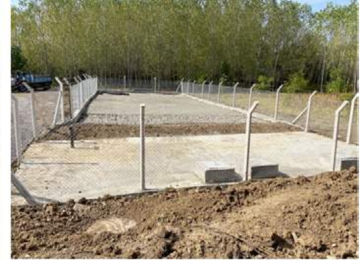
Taşköprü İlçesi Tavukçuoğlu Köyü Kanalizasyon Yapım İşi
