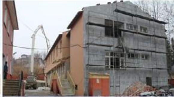
Araç Çok Programlı Lisesi Pansiyon Binası Güçlendirme ve Onarım İşi
