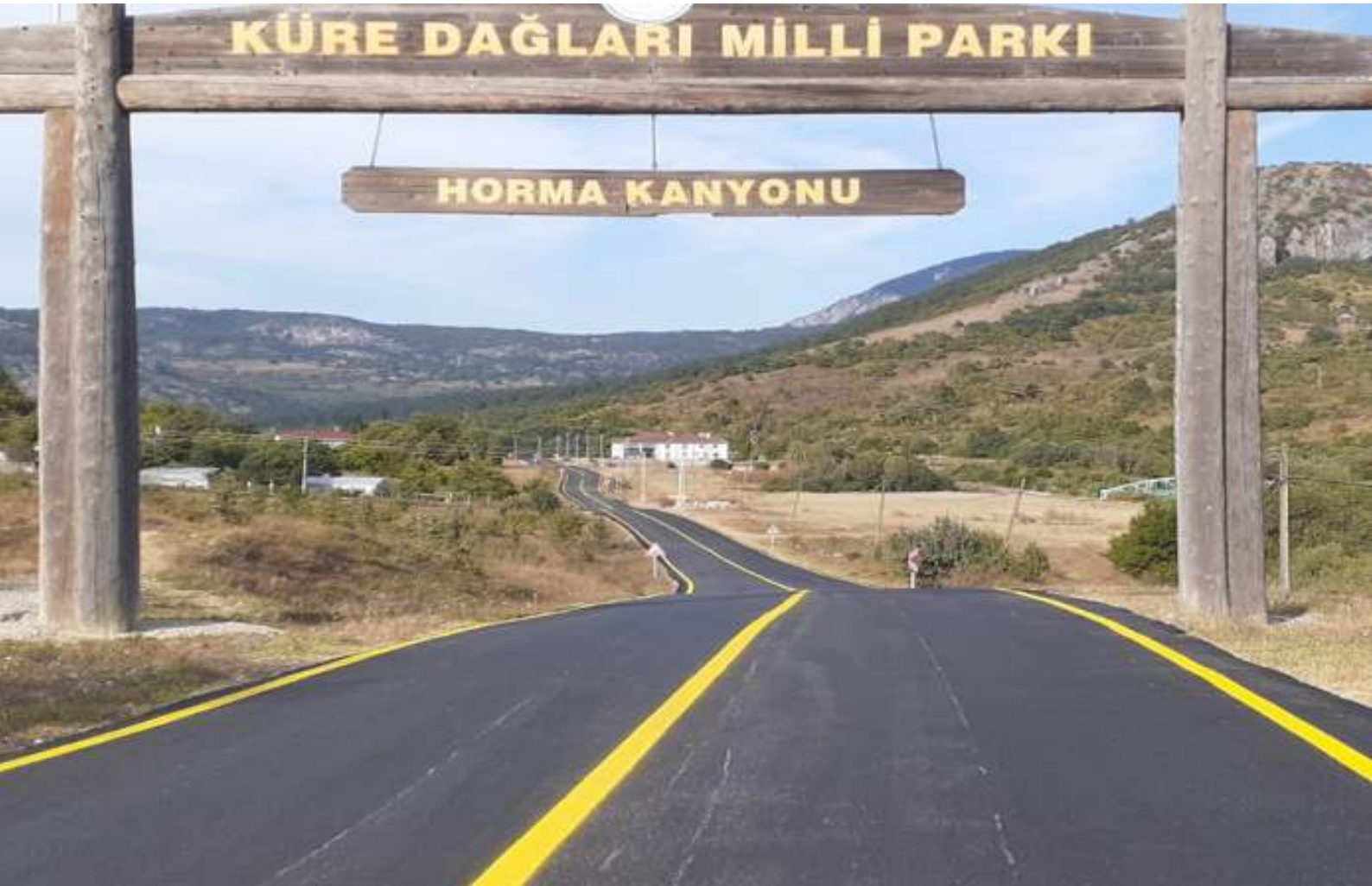
CİDE İLÇESİ GÖKÇEÖREN – KOVANÖREN – TOYGARLI – ALAYÜZ GR.KY. BSK YOL ÇALIŞMASI 7,80 KM
