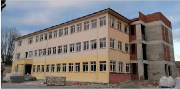
Taşköprü Anadolu İmam Hatip Lisesi Güçlendirme ve Onarım İşi
