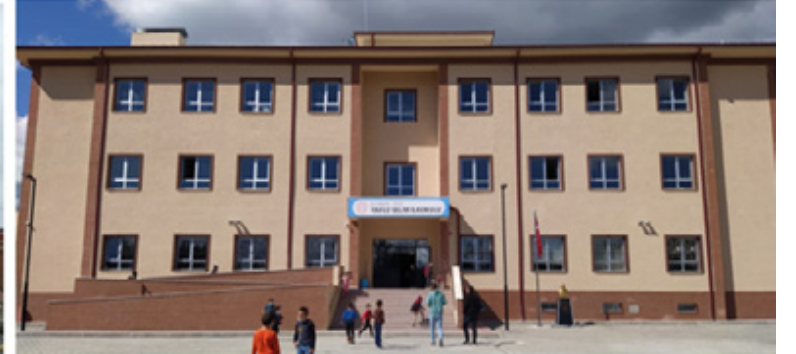
Tosya Yavuz Selim İlkokulu 12 Derslikli Okul Binası Yapım İşİ
