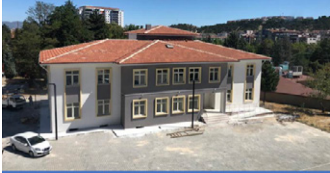
Merkez Yerel Ölçme ve E-Sınav Merkezi Yapım İşi
