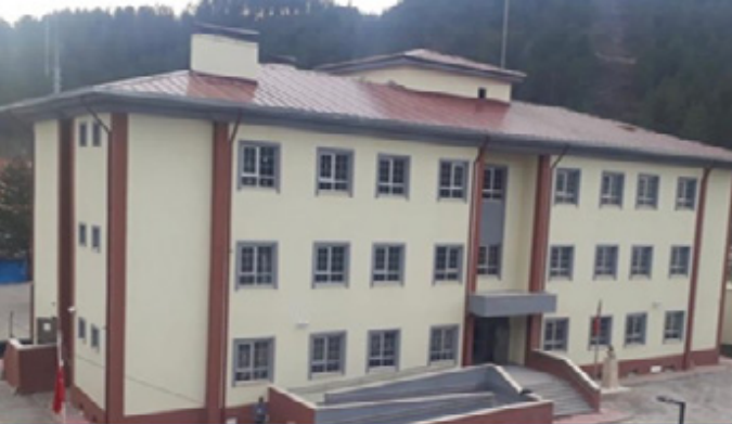
Şenpazar Ortaokulu 12 Derslik Okul Binası Yapım
