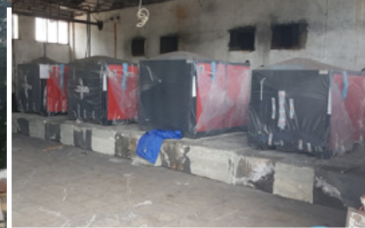
Kastamonu Jandarma Komando Eğitim Alay Komutanlığı'nda Bulunan Muhtelif Binaların Doğalgaz Dönüşüm İşi
