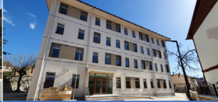
Merkez Behçet Necatigil 8 Derslikli İlkokul Binası Yapım İşi
