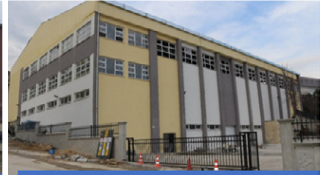
Merkez Mustafa Kaya Lisesi Spor Salonu Yapım İşi
