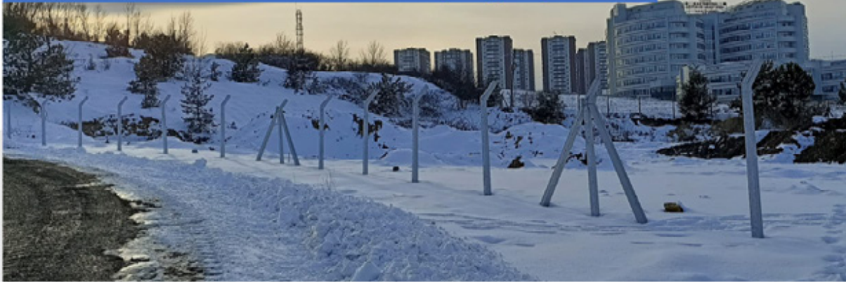
İl Özel İdaresi ve Ek Hizmet Binası Yerleşkesine Güvenlik Amaçlı Beton Direkli Tel Çit Yapım İşİ
