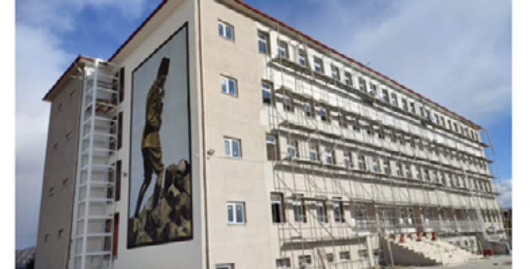
Tosya Kız Anadolu İmam Hatip Lisesi Güçlendirme ve Onarım
