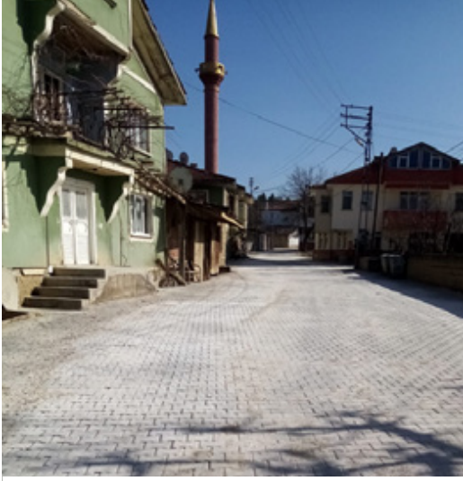
Merkez İlçe Gömeç Köyü Parke Yapımı
