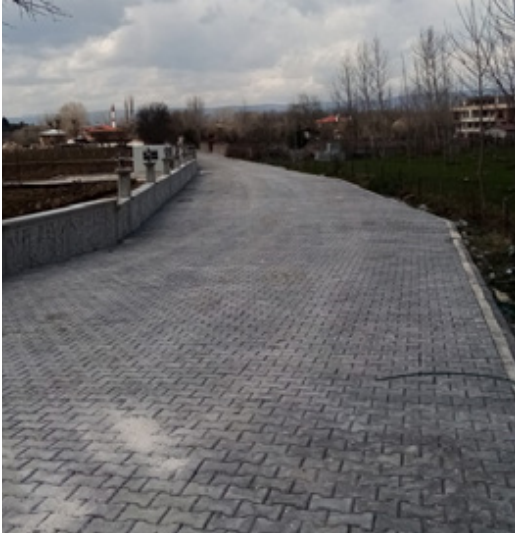
Merkez İlçe Kuru Köyü Parke Yapımı
