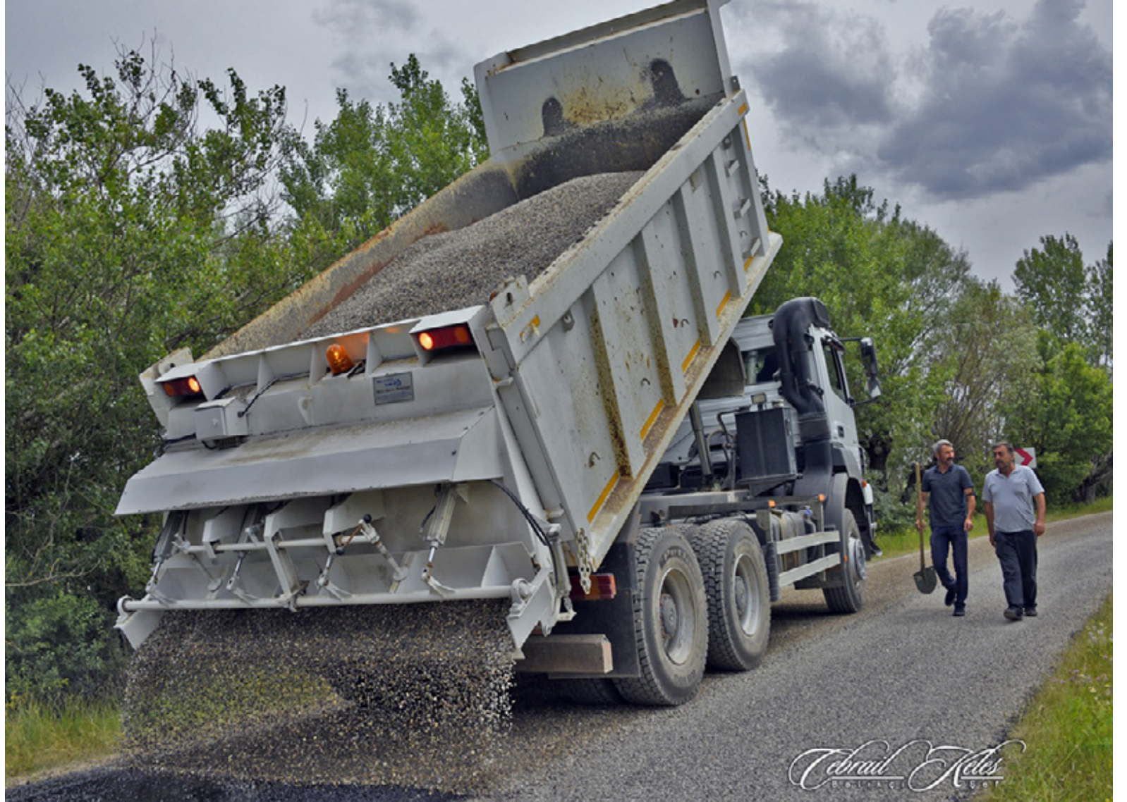
Seydiler İncesu 3,50 km. 2. Kat Asfalt Sathi Kaplama
