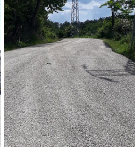
Seydiler İncesu 3,50 km. 2. Kat Asfalt Sathi Kaplama
