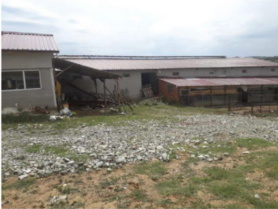
Sağ Yan Cephe
