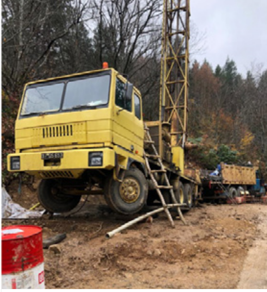
Bozkurt Kocaçam Köyü Sondaj Çalışması
